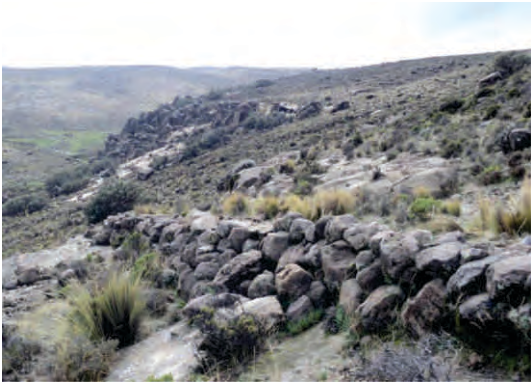
FOTO 12. Vista del muro de contención Camino Altarani- Huayllane.
