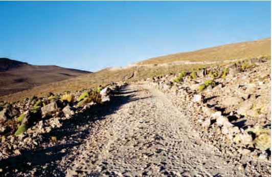
FOTO 5. Camino despejado con alineamiento de piedras en sus bordes localizado en Chilligua.
