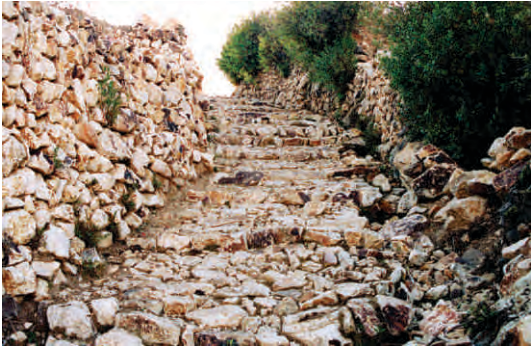
FOTO 2. Camino empedrado con escalones y muros de contención en ambos lados localizado en la localidad de Ichuña.
